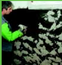
Nanošenje KÖSTER Reparturni mort
