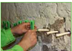
Postavljanje KÖSTER Kutnih nosača
