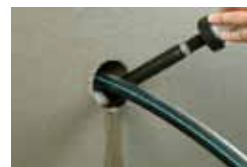
2. ... prodor kabela se...
