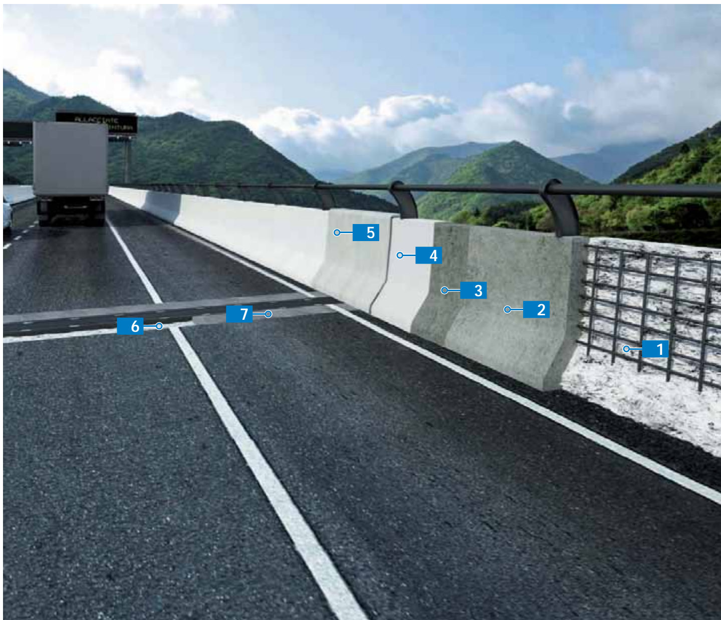
Sanacija "New Jersey" ograda i dilatacija na autoputu
