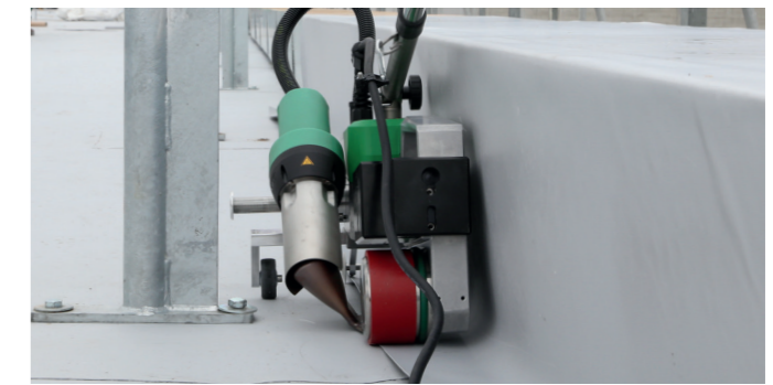
Mühelos schweisst der UNIROOF auch alle schwer zugänglichen „Dach-Problemzonen“
