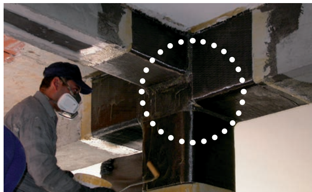
GORE: Protupotresna ojačanja školskih zgrada sustavom MAPEWRAP EQ (lijevo) i tkaninama MAPEWRAP (desno).
