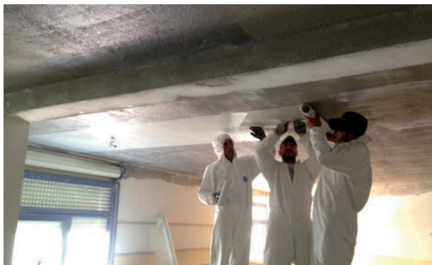
GORE: Protupotresna ojačanja školskih zgrada sustavom MAPEWRAP EQ (lijevo) i tkaninama MAPEWRAP (desno).
