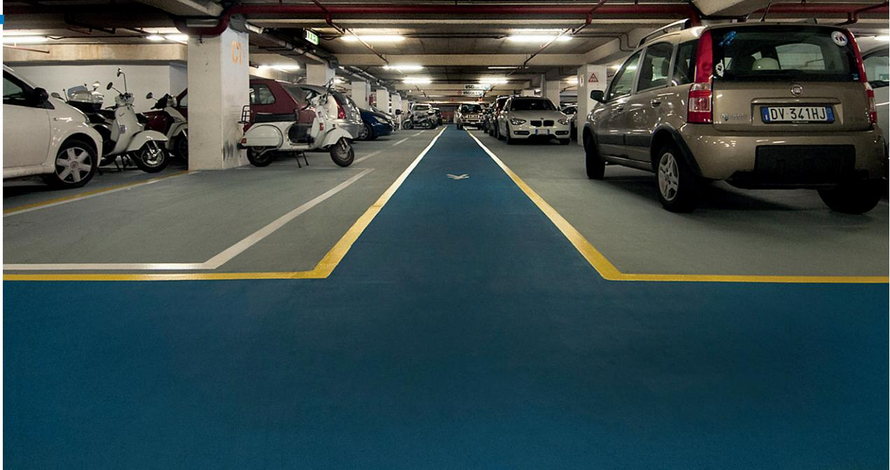
Višeslojni epoksidni sustav bez spojeva za pješačke površine i površine izložene intenzivnom prometu vozila. Sustav je u skladu sa smjernicama Rili DafStb (Smjernice njemačkog odbora za armirani beton) OS 8 i sustavima zaštite površine betona prema EN 1504-2; debljine od 3 do 3,5 mm.
