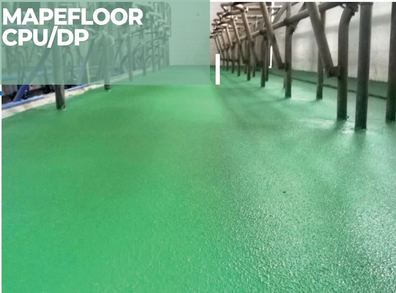
Višeslojni protuklizni cementno-poliuretanski sustav visoke mehaničke čvrstoće i otpornosti na kemikalije, za izvedbu industrijskih podova; debljine od 3 do 4 mm.
