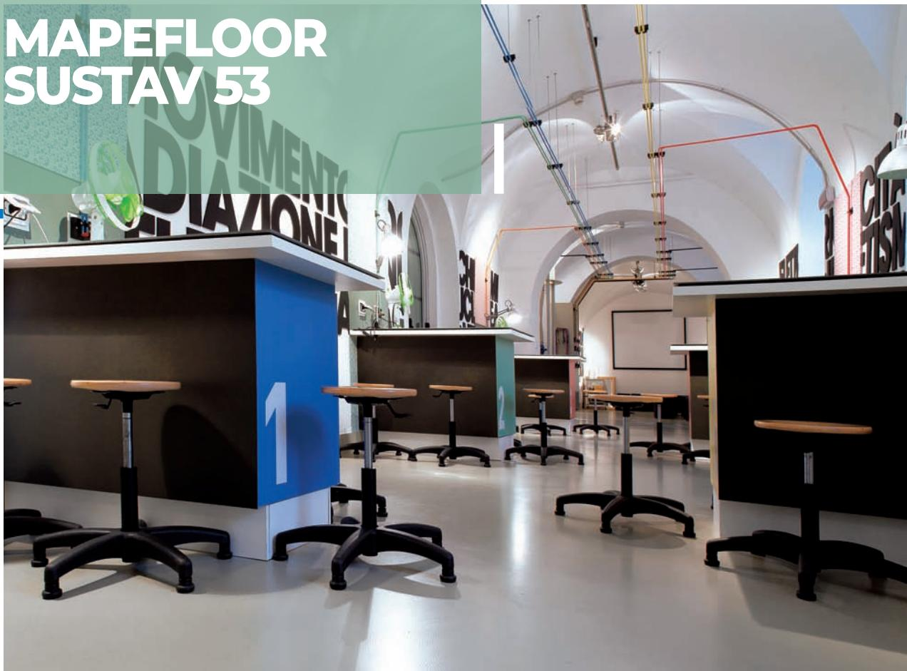
Samoizravnavajući paropropusni epoksidni sustav u vodenoj disperziji s mat glatkim završnim izgledom; za debljine do 4 mm.
