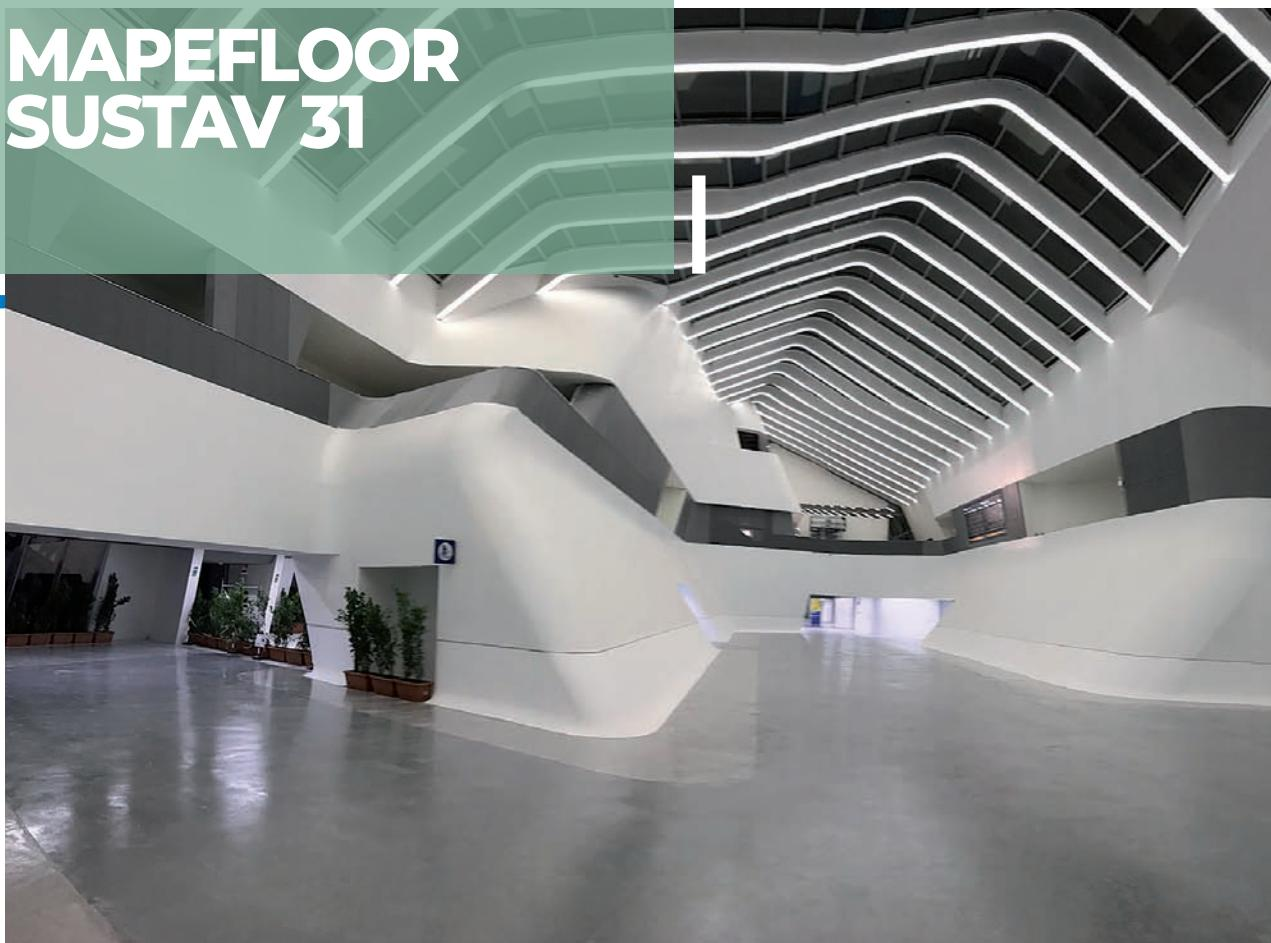
Višeslojni epoksidni protuklizni sustav za industrijske podove; debljine od 0,8 do 1,2 mm.
