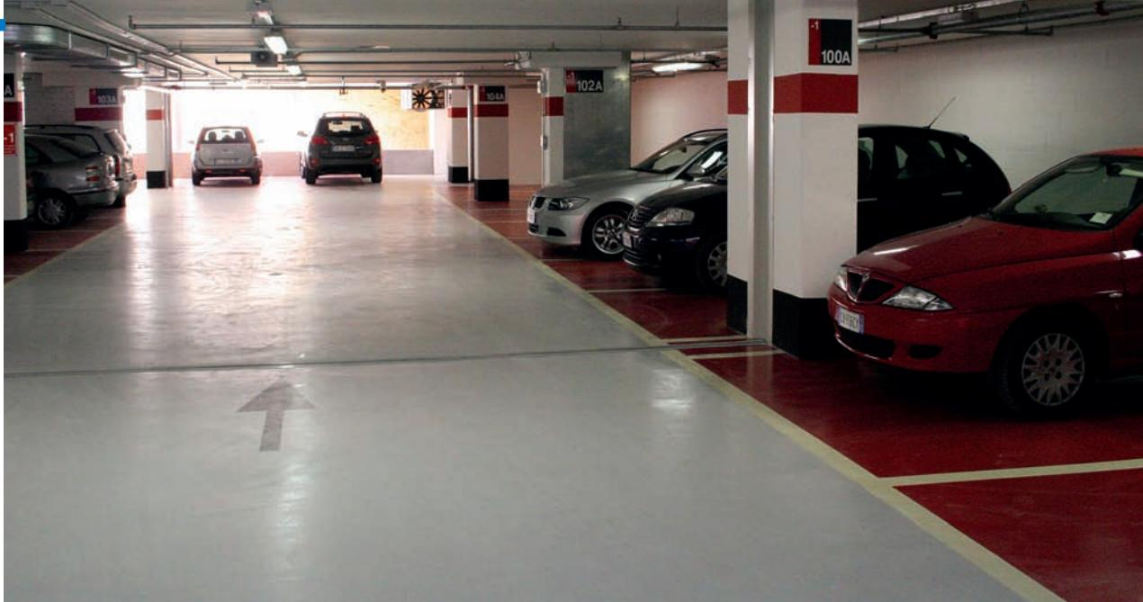
Višeslojni poliuretanski sustav bez spojeva, s visokim kapacitetom premoštenja pukotina na pješačkim površinama i površinama izloženim intenzivnom prometu vozila, također i na otvorenim površinama. Sustav je u skladu sa smjernicama Rili DafStb (Smjernice njemačkog odbora za armirani beton) OS 11b i sustavima zaštite površine betona prema EN 1504-2; debljine od 4 do 4,5 mm.
