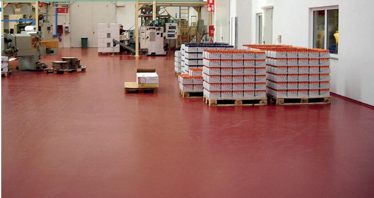
Višeslojni paropropusni epoksidni sustav u vodenoj disperziji s mat protukliznim završnim efektom, za industrijske podove; prosječna debljina 3 mm.
