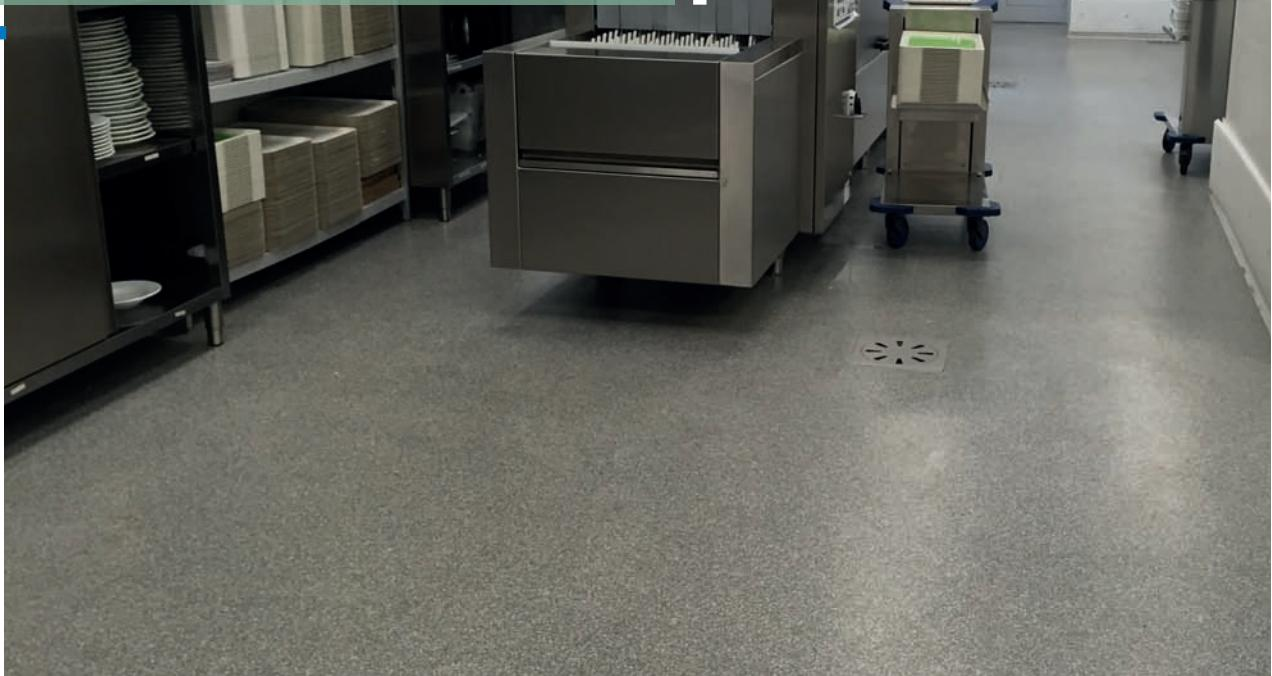
Višeslojni dekorativni epoksidni sustav s vrlo atraktivnim završnim izgledom za industrijske i komercijalne podove; debljine od 2,5 do 3,0 mm.
