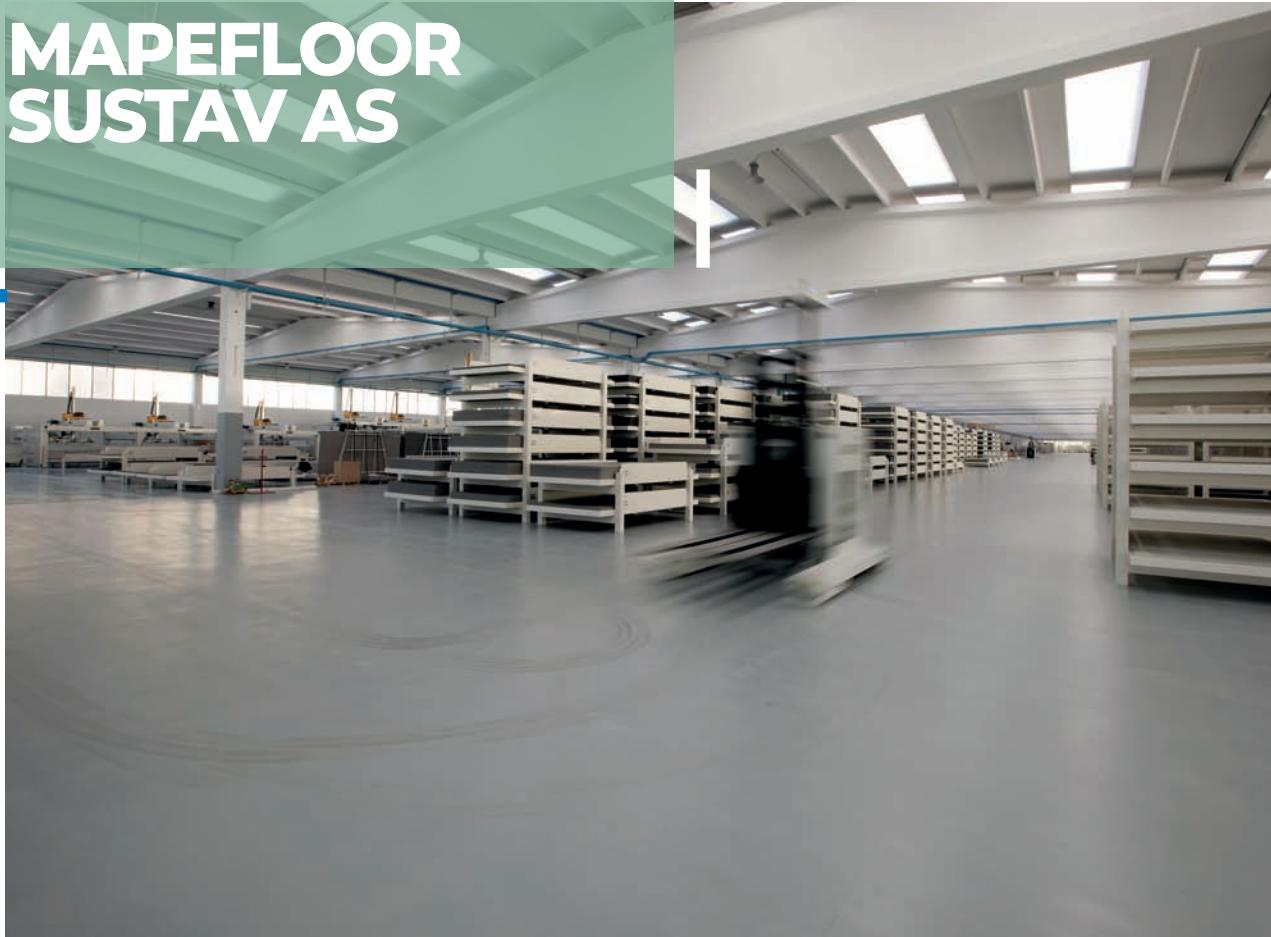
Samozravnavajući epoksidni sustav za anti-statik, elektro-provodljive industrijske podove; debljine od 1,5 do 2 mm.
