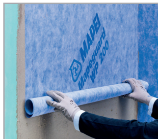
Ugradnja hidroizolacijske tkanine Mapeguard WP 200.
