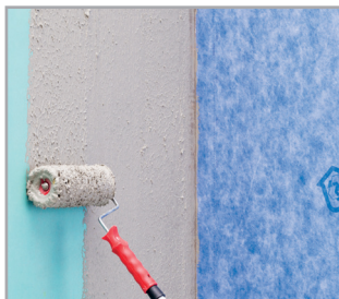
Nanošenje valjkom ljepila Mapeguard WP Adhesive.
