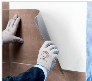
Polaganje LVT ploče na zid ljepljom Ultrabond Eco MS 4 LVT Wall.
