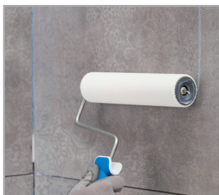
Nanošenje protukliznog zaštitnog premaza Mapecoat 4 LVT.
