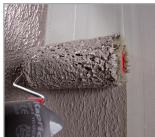
Nanošenje prvog sloja hidroizolacije Mapelastic Turbo valjkom.
