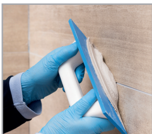
Fugiranje masom Kerapoxy 4 LVT.
