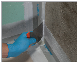
Pravilno izodjenje hidroizolacije unutarnjeg kuta trakom Mapeband Easy.
