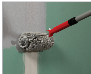
Nanošenje prvog sloja hidroizolacije Mapelastic Aquadefense.
