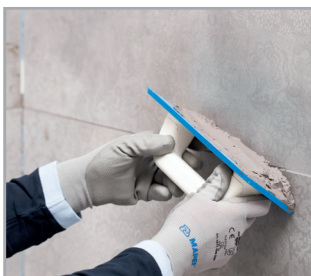
Fugiranje masom Kerapoxy 4 LVT.
