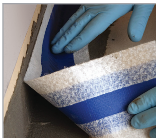
Ugradnja Mapeband trake.
