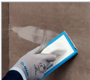
Fugiranje masom Kerapoxy 4 LVT.
