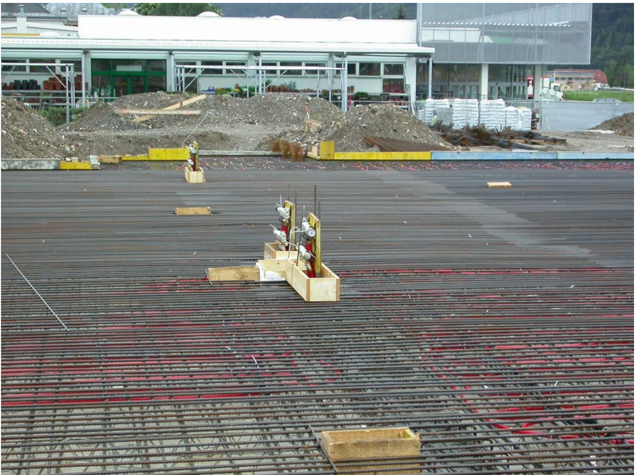
Aktivacija betonske jezgre zida sa Hitherm registrima
