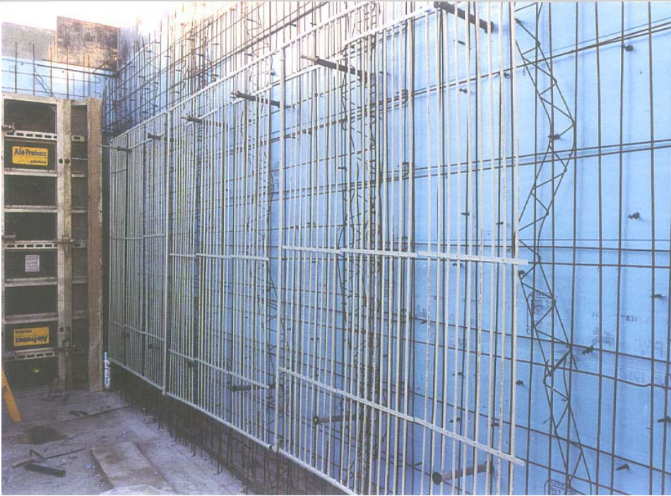
Aktivacija betonske jezgre zida sa Hitherm registrima
