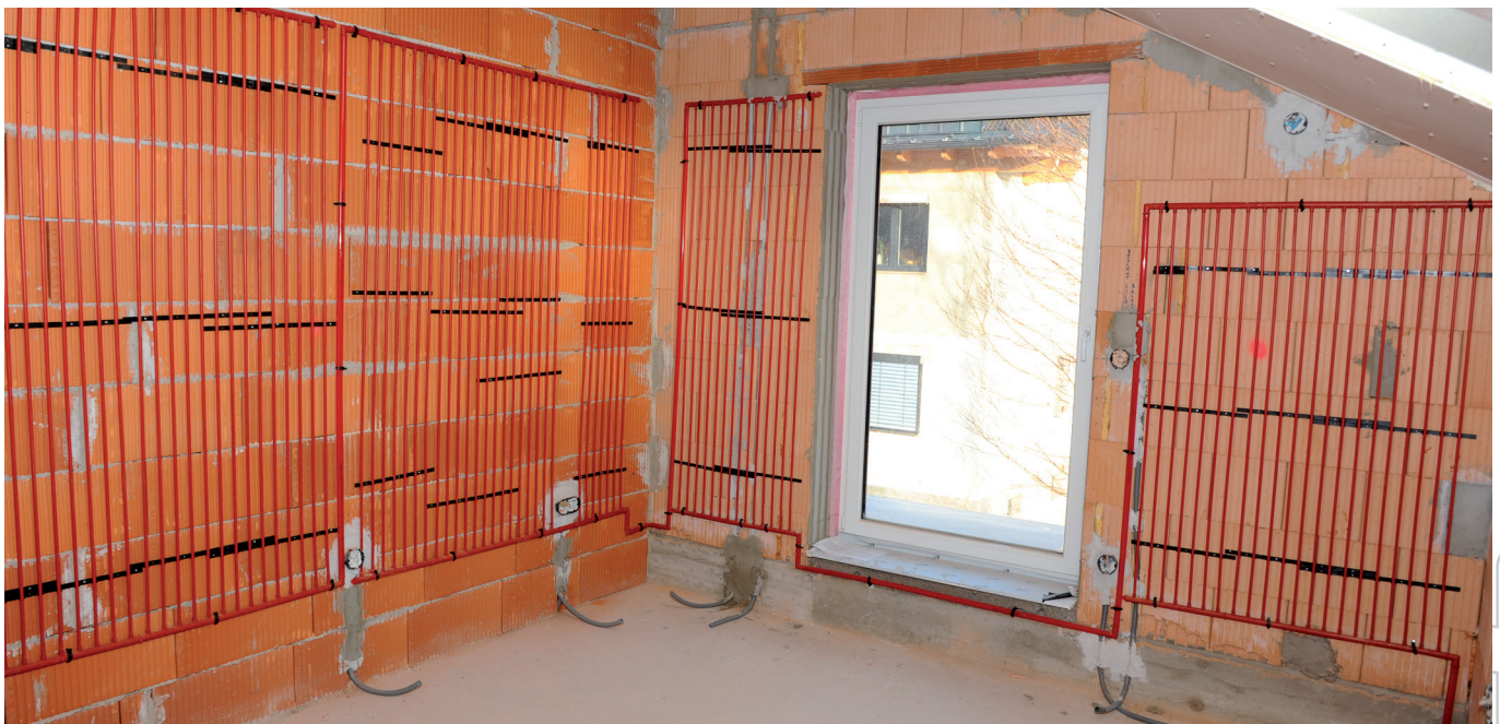
Posebno se preporučuje: blaga toplina zračenja sa sustavom Hitherm® uz hladne staklene površine.
