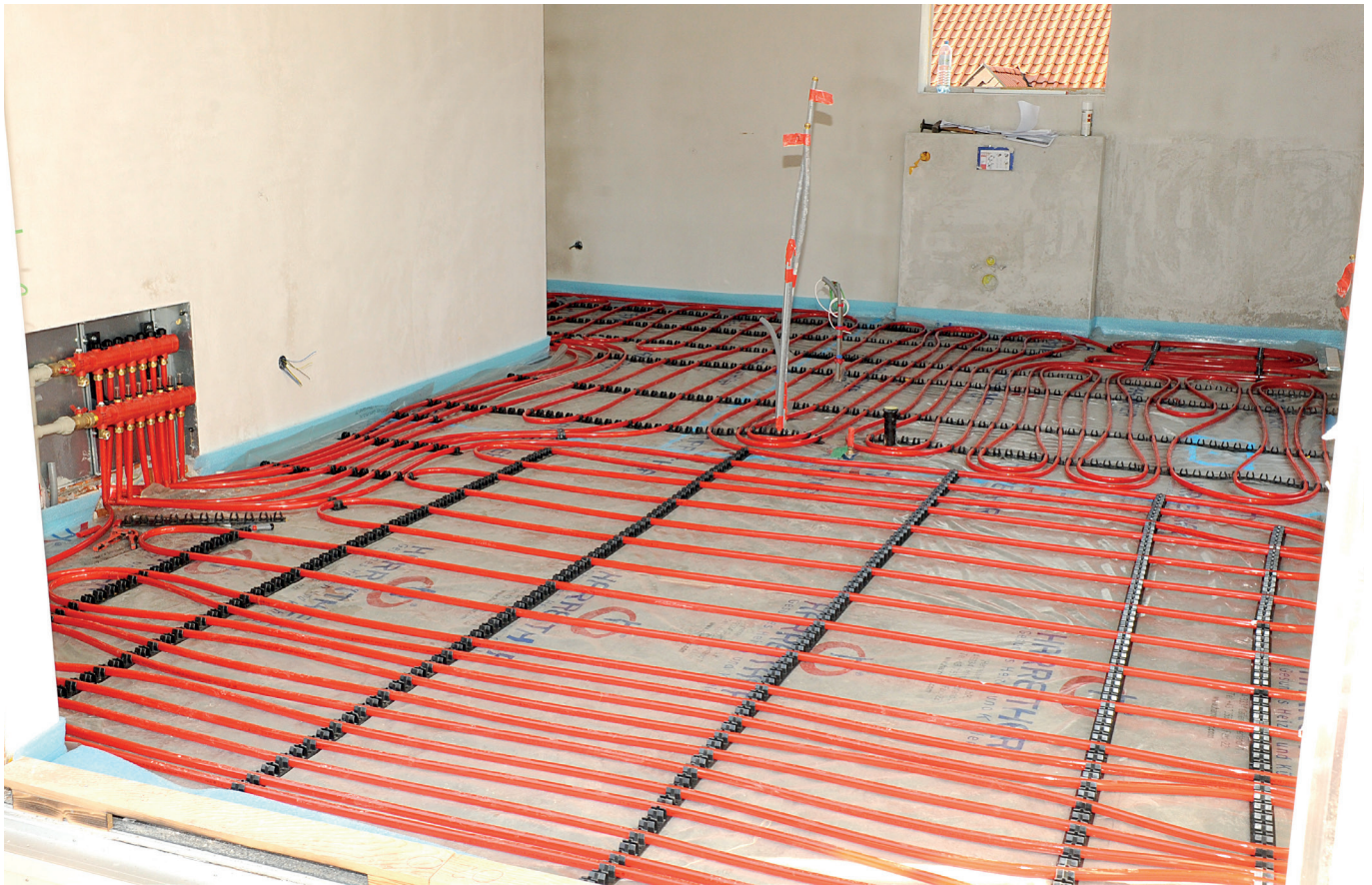
U području vanjskog zida postiže se veća snaga grijanja zahvaljujući užem razmaku pri postavljanju.
