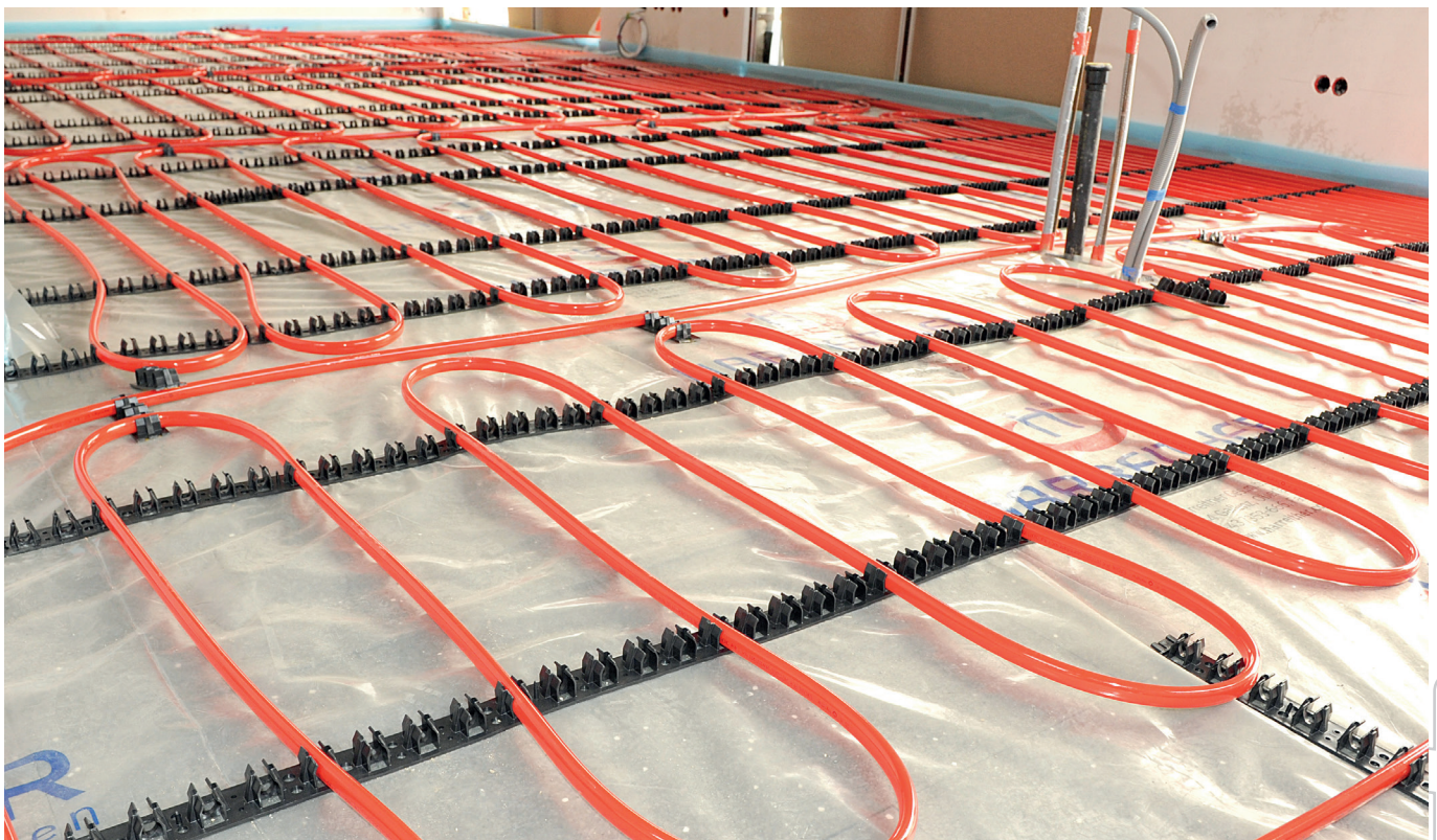
Veće prostorije podijeljene su u nekoliko krugova grijanja. Ovalna geometrija jamči savršen položaj cijevi u luku.
