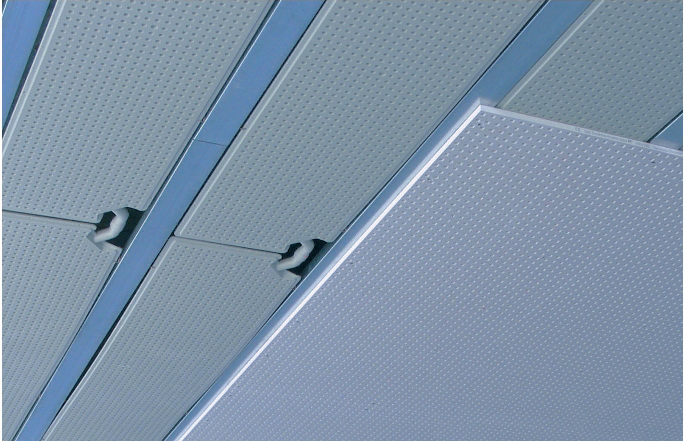
Kontakt između modula elemenata i oplata po cijeloj površini osigurava optimalan prijenos energije.
