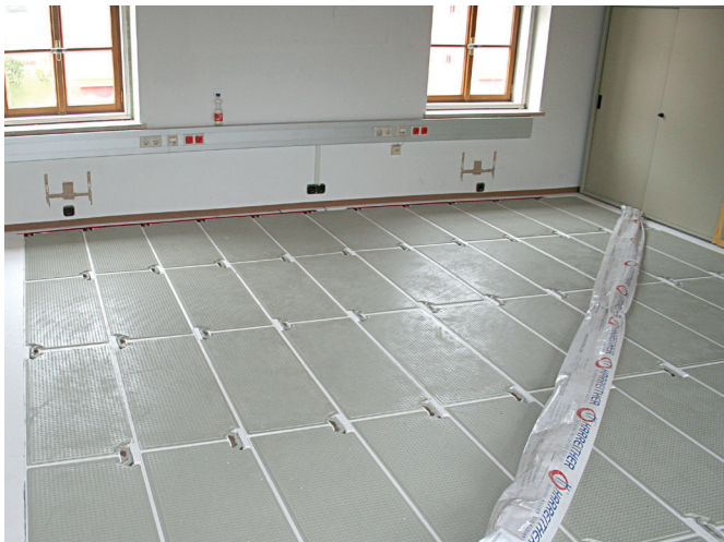
U ovom uredu izveden je dizajn cijele površine s modulom klima-pod.
