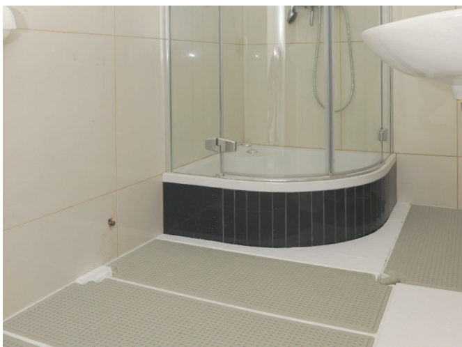
Adaptacija kupaonice s brzo reagirajućim modulom klima-pod.
