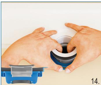
DE Den unteren Ring des Flex-Elements zum Ventilteiler ziehen
