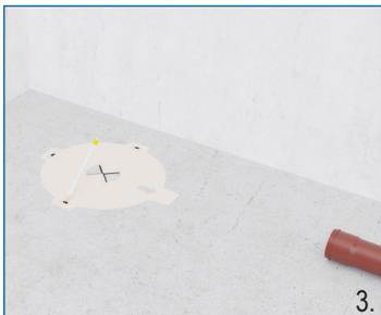
DE Montageschablone in Richtung Abflussrohr auflegen und Löcher für die Bohrungen markieren.
