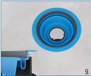
DE Abdichtgarnitur mit integriertem Flex-Element in den Ablauf einstecken, Bauschutz umdrehen und wieder einsetzen.
