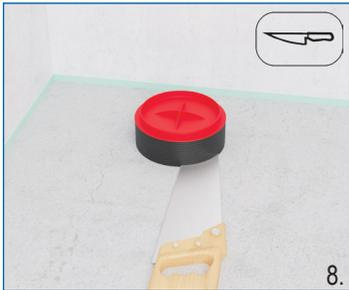
DE Nach dem Aushärten des Estrichs den herausstehenden Rohrstützen estrichbündig mit einer Säge abschneiden.
