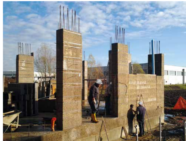
STUP 25cmx25 cm s izolacijom na tri strane od 5cm EPS-a s GRAFITOM + 3,5 drvobetona
